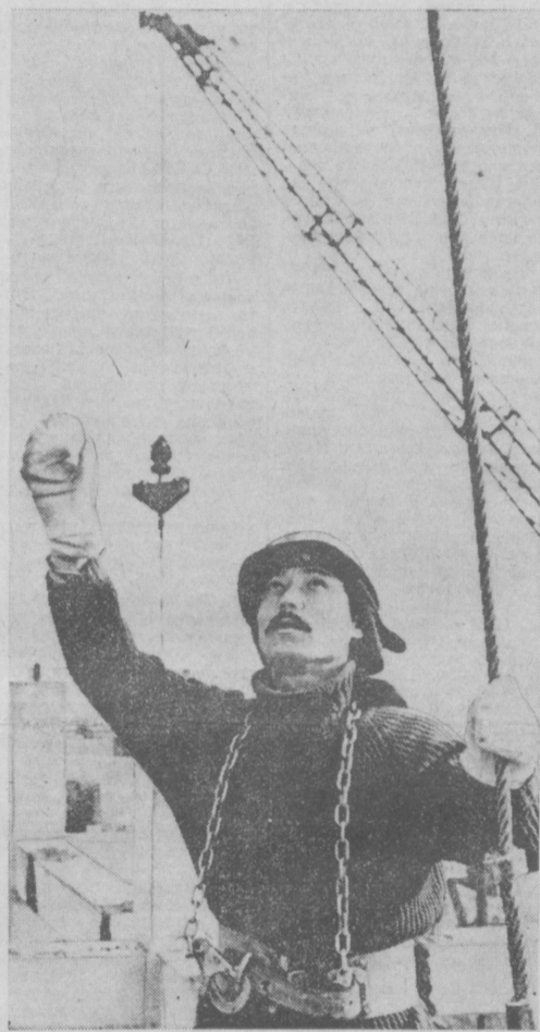
Комплекс Ташкентского автомобильного института, в который входят два учебных и лабораторных корпуса, библиотека, спортивный зал, столовая и другие сооружения, возводятся на улице Пролетарской. Строит его комплексные бригады строительного управления треста № 8 Главташцентрострой. Первый корпус они обязались сдать в эксплуатацию в начале 1978 года. На снимке: передовой монтажник, ударник коммунистического труда комсомолец Марат Валиев. Фото Р. ШАГАБОВА (УзТАГ).
