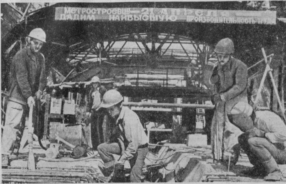
Хорошо потрудились в день «красной субботы» строители бригады И. Голубева на сооружении станции Хамиды Алимджана Ташкентского метро. На снимке: члены бригады за работой. Фото А. ГОРОКРИКА (УзТАП).
