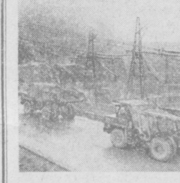
Нуренская ГЭС — крупнейшее гидротехническое сооружение Средней Азии. Шестые агрегаты выработают уже около 12 миллиардов киловатт-часов электроэнергии. На снимке: БелАЗы доставляют грунт для отсыпки высотной плотины.
