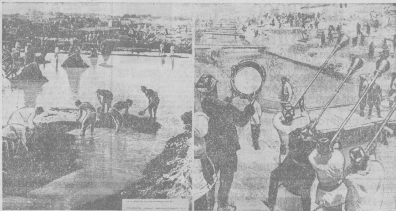
Строительство Большого Ферганского канала.
