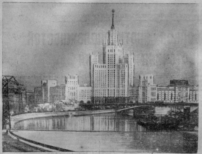
Москва. Новое высотное здание на Котельнической набережной. Фото Н. Грановского. (Фотохроника ТАСС).
