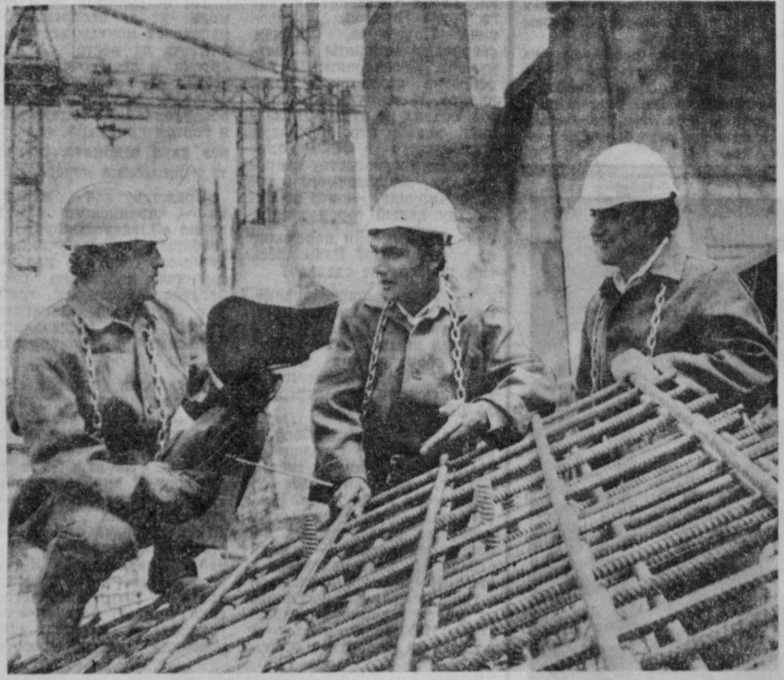
Тумуюн. На строительстве крупнейшего гидроузла предстоит знаменательное событие. Осенью будет перекрыта Аму-Дарья. Когда гидроузел войдет в строй, неузнаваемо преобразятся окрестные места. Богатырские импугасы получат экономника. Эти трое, которых вы видите на снимке, — ветераны стройки. Знакомьтесь: (слева направо) монтажники Курбанов, Туранджон Шарипов и бригадир комплексной бригады Земляной Тедева.
