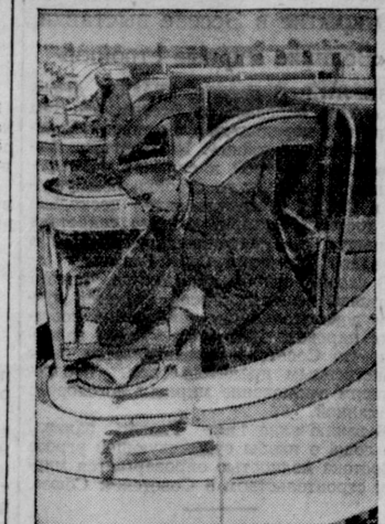
Коллектив механизаторов 1-й Хатларинской МТС, Самаркандской области, успешно проводит ремонт хлопкоборных машин, обеспечивая готовность машинного парка к предстоящей уборке хлопка-сырца. Большая часть машин уже отремонтирована. На снимке: механик-водитель Ибрагим Ходяев, выполняющий дневную норму по ремонту хлопкоборных машин до 250 процентов.
