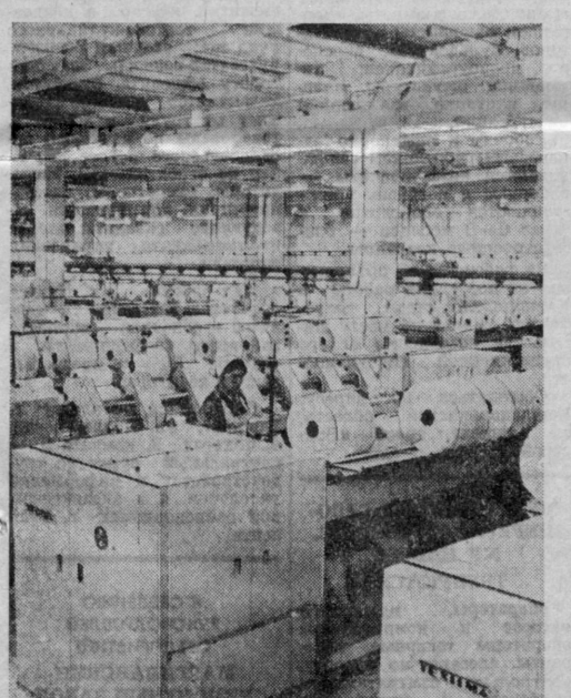
Новые гребенчатые и лентосоединительные машины фирмы «Текстима» (ГДР) установлены на второй и третьей фабриках Ташкентского текстильного комбината. Благодаря их производительности оборудование возросло здесь на 70 процентов, а производительность труда — на 44 процента. Значительно улучшились условия труда на второй ткацкой и ниточной фабриках, где старые станки заменены металлическими автоматами мехобслуживающей фирмы «Утосун». Гребенчатая Комета Хантоджиева на машинах «Текстима» постоянно переплывает смежные задания. Фото Р. ШАМСУДИНОВА (УзТАП).
