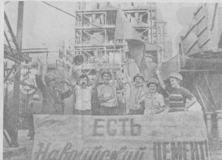
В «Правде Востока» уже сообщалось о том, что стала выдаваться впервые первая очередь Навоийского цементного завода — крупнейшего предприятия строительной индустрии Средней Азии. Этот снимок сделан фотореспондентом Узбекского информационного агентства Р. Габуриным в радостный для коллектива строителей и эксплуатационников день.
