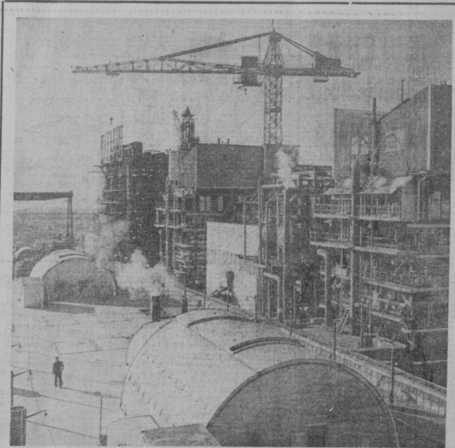
Как уже сообщалось в «Правда Востока», строители Новоширской ГРЭС сдают под промышленную нагрузку два турбогенератора. С опережением графика идет монтаж третьего агрегата, мощность которого — 150 тысяч киловатт. В 1963 году освоены десятки тысяч рублей сверхплановых капиталовложений. В первом квартале нового года сдан турбогенератор вступил в строй. Станция, работающая на природном газе, будет подключена к энергетической системе Узбекистана. На снимке: котлы и турбины Новоширской ГРЭС. Фото Г. Луна. (Фотохроника УЗТАГ).
