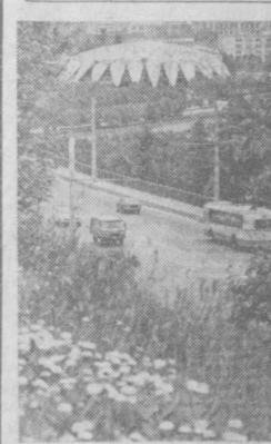
Москва готовится к Олимпиаде-80. На снимке вид из строящегося универсального спортивного зала на Лужнецкой набережной.
