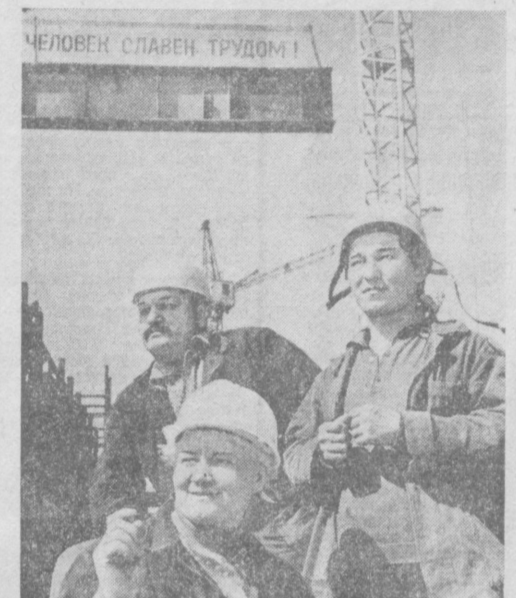
В Ташкенте идет сооружение уникального комплекса — киноинтерактивного зала на 4100 мест. Это будет здание из стали, стекла и бетона. Сейчас на стройке важный период — монтаж металлоконструкций. На этих работах отличаются передовые строители, которых вы видите на снимке, — И. Лазоренко, А. Мырмык и М. Утемураев.
