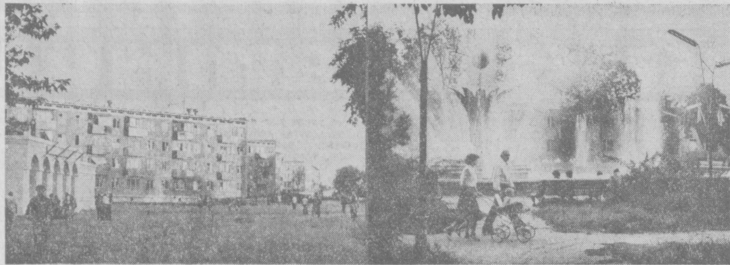
На Маргиланском шелковом комбинате уделяют большое внимание жилищному строительству. Ныне для рабочих предприятия будет построено четыре дома. Изображены условия улучшат 176 семей. На снимках: слева — новые дома в городе шелковиков, справа — один из уголков жилищной застройки. Фото Н. ДУШКИНА (УзТАГ).
