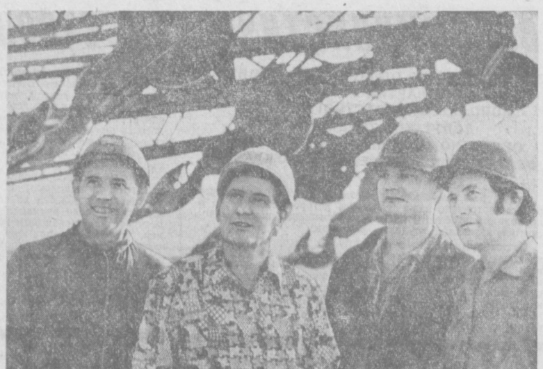
Бригада, которой руководит коммунист Александр Григорьевич Сукачев, по праву считается лучшей во втором управлении тагикского треста «Строймеханизация». Коллектив занят монтажом башенных кранов. Применяя передовые методы, монтажники систематически выполняют план на 130—140 процентов. На снимке: бригадир Александр Сукачев (второй слева), монтажники Александр Смирнов, Валерий Иванов и Владимир Громов.
