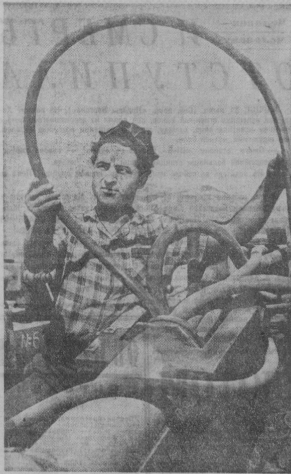
В долине Чирчика строится Чарвакский гидроэлектростанция — крупнейшая гидроэнергетическая стройка нашей республики. На снимке М. Сироткина и Н. Гамбарова — бригады комбинской бригады производителей Михаила Тугуца. Возле строящегося моста бригады строят один из пяти обводных тоннелей, систематически перевыполняют свои производственные задания.
