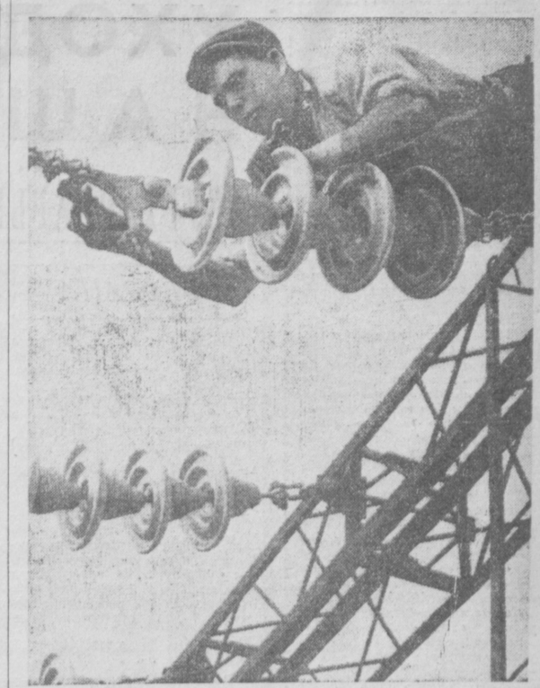
На трассе Аму-Бухарского канала заканчивается сооружение Алатской электростанции, ток от которой будет питать мощные насосные установки для орошения земель колхозов и совхозов. На снимке: электромонтажник Владимир Ульянов на монтажных работах. Фото А. Усманова. (Фотохроника УЗТАП).
