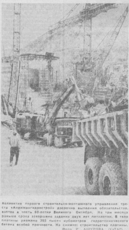
Коллектив первого строительного-монтажного управления треста «Андижангидрострой» досрочно выполнил обязательство, взятое в честь 60-летия Великого Октября. На три месяца раньше срока завершено задание двух лет пятилетки. В тело плотины уложено 365 тысяч кубометров гидротехнического бетона высшей прочности. На снимке: строительство плотины.
