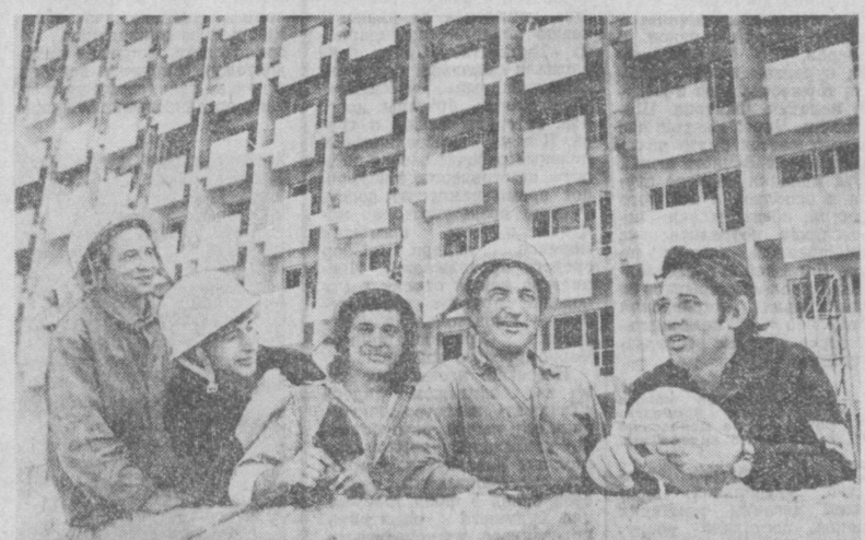
На пусковом объекте — гостинице «Делинград» трудятся эти парни (на снимке слева направо): Г. Малинов, А. Пулатов, П. Лапин, А. Захаров и бригадир А. Картушин. Они
