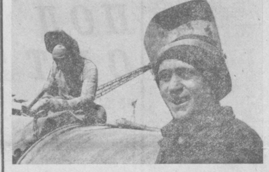
Ударило трудиться на юбилейной акции строители Чустской передовой механизированной колонны треста «Наманганстрой». С начала года они произвели работ почти на два с половиной миллиона рублей. На снимках: сверху — идет монтаж Тепла-Курганской часовой станции. А по две нормы выполняет ежедневно сварщик Тимофей Галуза (на нижнем снимке справа). Фото Х. ХАЛДАРОВА (УзТАП).
