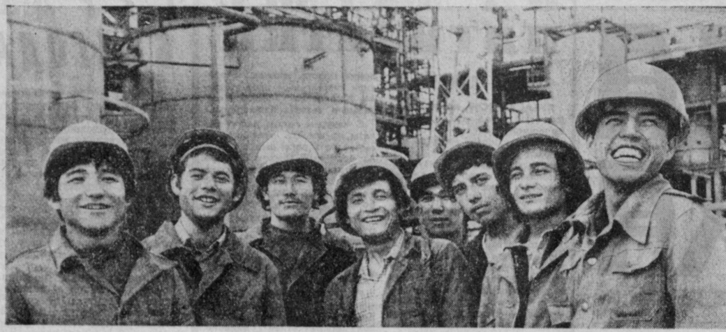
Отлично работает на строительстве Чирчинского комплекса по производству напольных плит бригада Анджианского стройтреста...
