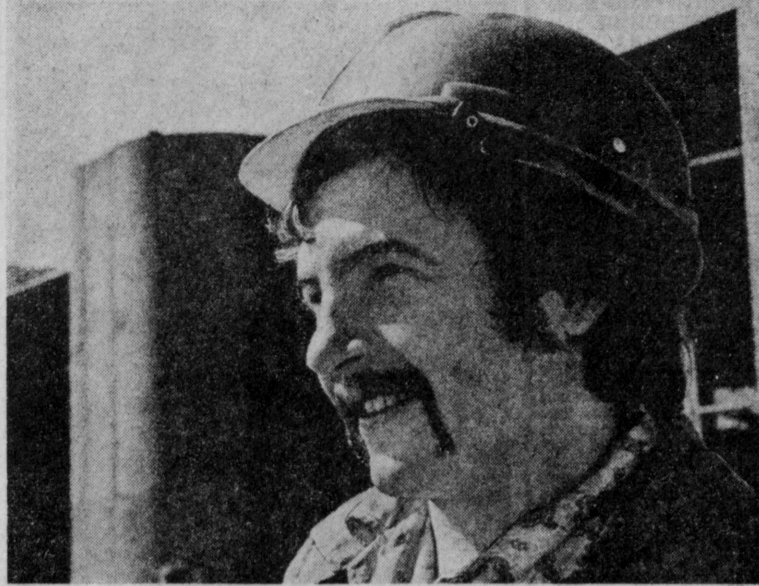
Продолжается строительство Газалинградской ГЭС. Это третья — после Чарвакской и Ходжинкентской — гидроэлектростанция каскада. На снимке: монтажники металлоконструкций Виктор Бражник — один из передовиков строительства. Фото И. ГЛАУБЕРЗОНА и В. СИРОТКИНА.
