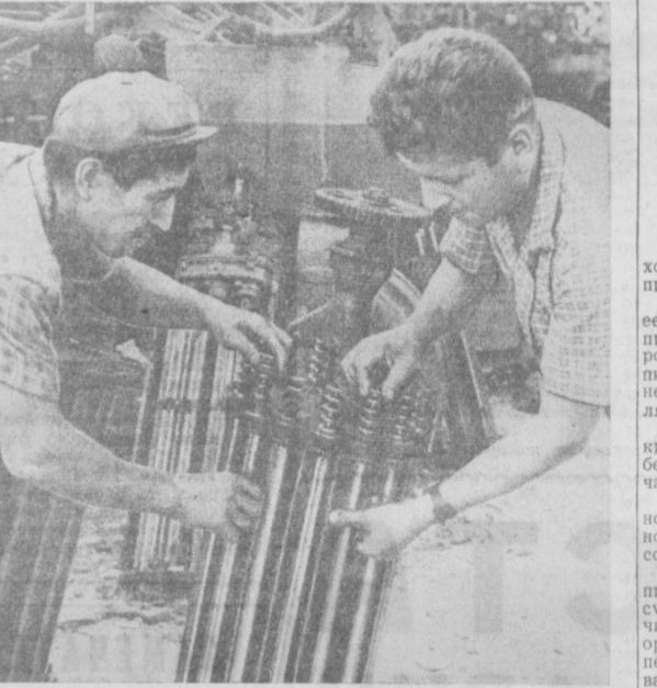
В совхозе «Балут» № 1 Янгйерского производственного управления полным ходом идет ремонт хлопкоуборочной техники. Механизаторы решили подготовить все агрегаты к 25 августа. На снимке: инженер совхоза Рефат Нурмаметов (справа) и помощник механика четвертого отделения Извет Досманбетов проверяют отремонтированные шпиндели хлопкоуборочной машины.
