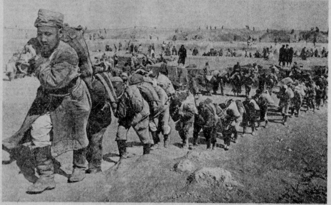
На строительстве Большого Ферганского канала. 1939 год.
