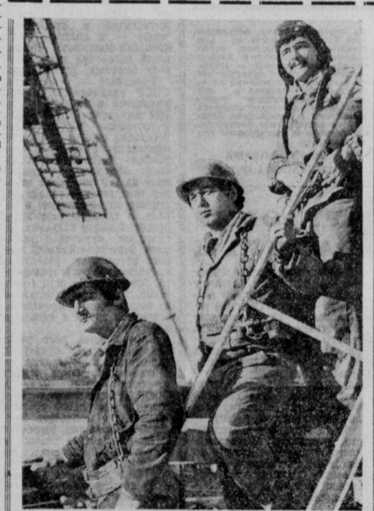
На монтаже металлоконструкций воздушной линии в Ташкенте новой телевизионной башни широко применяется автоматическая электросварка опорных подкосов. Этот метод разработан Институтом электросварки имени Е.О. Патона. Он дает значительную экономию времени и металла. На снимке (слева направо): передовые электросварщики Ш. Исаяв, А. Чумарин и Ш. Хусанов, освоившие метод автоматической электросварки. Фото И. ГЛАУБЕРЗОНА.
