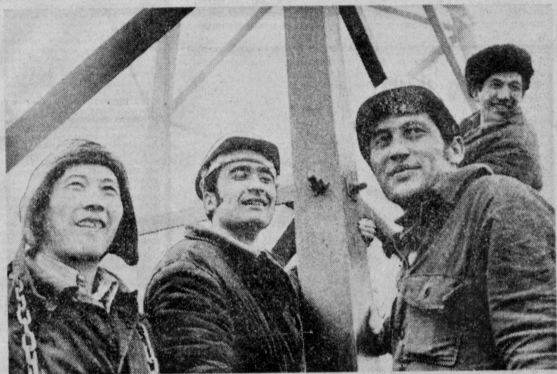
И в будни, и в праздники трудятся электромонтажники монтажного участка мехколонны № 4 треста «Узэлектрострой», где прорабом В. М. Колосов. В эти дни они выполняют срочную и важную для народного хозяйства Ферганской области работу — прокладывают высоковольтную линию протяженностью
