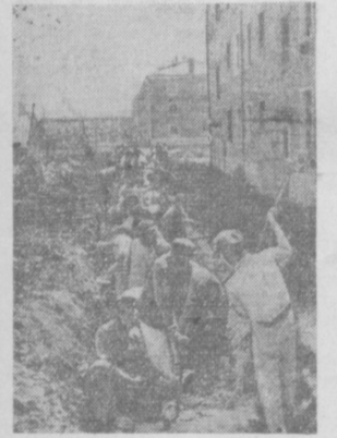
На снимке: строительство водопровода на окраине Пхеньяна. Фото Центрального телеграфного агентства КНДР.
