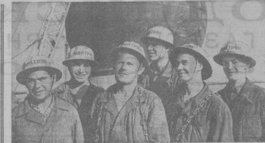
Бригада монтажников треста «Нефтегазстрой» (Ферганская область) в составе шести человек, смонтировала шаровую емкость объемом в 600 кубометров за десять дней. Это — рекордный срок. Достигнут он благодаря новой технологии изготовления сегментов шара, предложенной начальником монтажного управления М. Г. С. Сабировым и его сыном А. Г. Сабировым. На снимке: бригада монтажников, смонтировавшая шаровый резервуар в рекордный срок (слева направо): А. Кригер, Б. Анурьев, бригадир К. Фреге, В. Бала, Л. Децель, А. Фреге.
