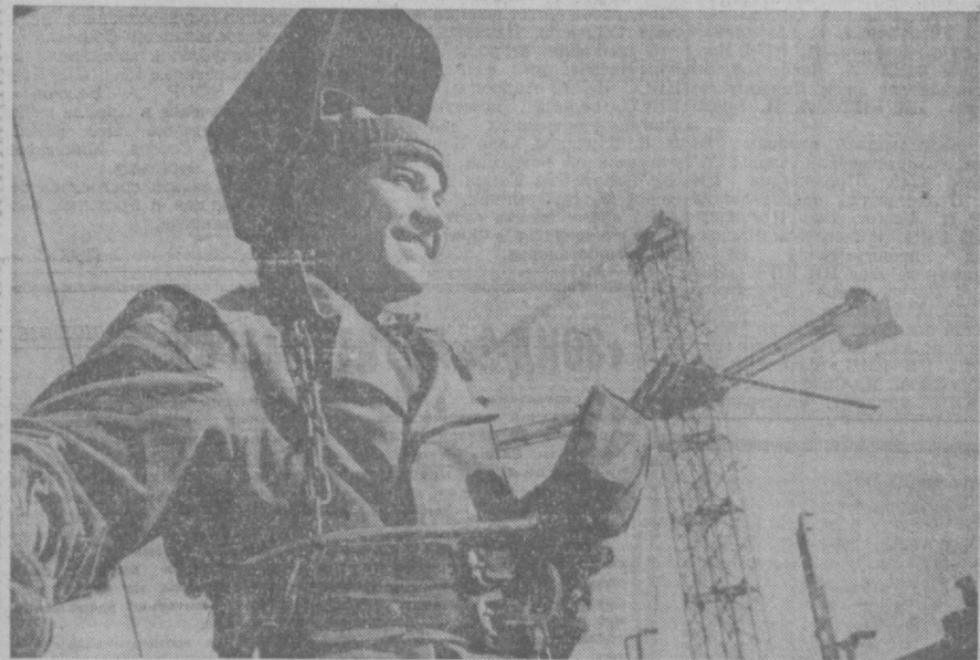
Это — лучший монтажник-электросварщик Петр Саранчев. На сооружении цеха производства аммиака он систематически перевыполняет сменные задания.
