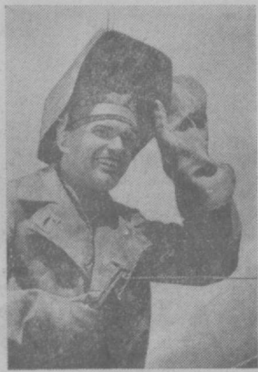
На трассе газопровода Бухара — Урал. Бригадир сварщиков Павел Торашев. Его бригада павела первые стыки звеньев труб газопровода.
