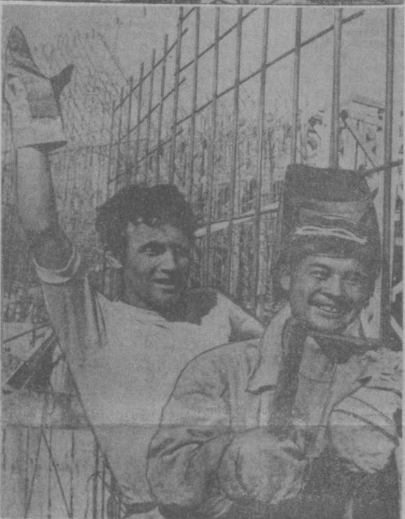
НА СНИМКАХ: сверху — один из участков строительства Южноуржумского водохранилища; внизу — электромонтер Юлдаш Чубаев (справа) и практикант, студент В. курса Ленинградского политехнического института Федор Каваловский, отличившиеся на сооружении катодного цеха.
