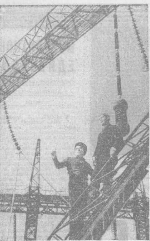
В Узбекском научно-исследовательском институте энергетиче- ской техники монтируется экспериментальная установка — генератор импульсного напряжения на три миллиона вольт. Новая установка — первая в Средней Азии — позволит значи- тельно расширить круг исследовательских работ. На снимке: инженеры лаборатории высоких напряжений института Ан- вар Сабирджанов и Абдулла Юлдашев принимают участие в монтаже установки.
