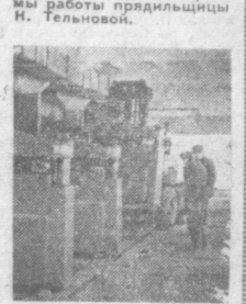
В Фергане поданы корпуса обустройства фабрики. В цехах начался монтаж оборудования. На снимке: слесари-наладчики Н. Котов и И. Садышев ведут монтаж конвейера.
