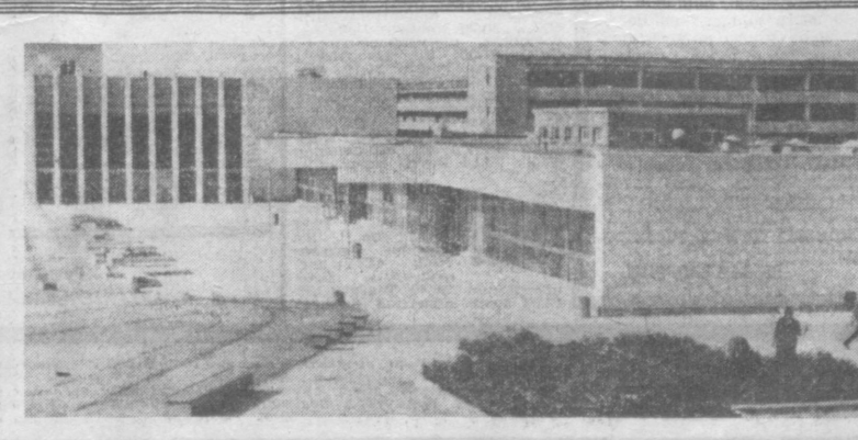
Торговый центр в молодом городе золотодобытчиков — Зарафиане.
