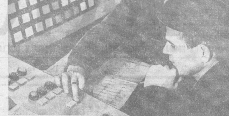
Большую помощь Навоийскому химическому комбинату оказывает коллектив Чирчинского филиала счетно-конструкторского бюро автоматизации (ОКБА). Сейчас в цехе аминной селитры швы помогают устанавливать новый пульт управления производством, который объединит две очереди. На снимке: руководитель наладочной группы Игорь Кутявин и техник-наладчик Марат Вафин проводят испытания узлов автомата.
