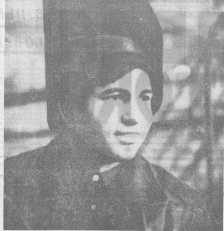
На Тойтинском заводе металлоконструкций слабой передовой производительности заслуженно пользуется электросварщик Шейкет Мейитов. Он участвует в соревнованиях за досрочное выполнение пятилетки. Свои задания Шейкет систематически перевыполняет. Фото А. ТУРАЕВА.
