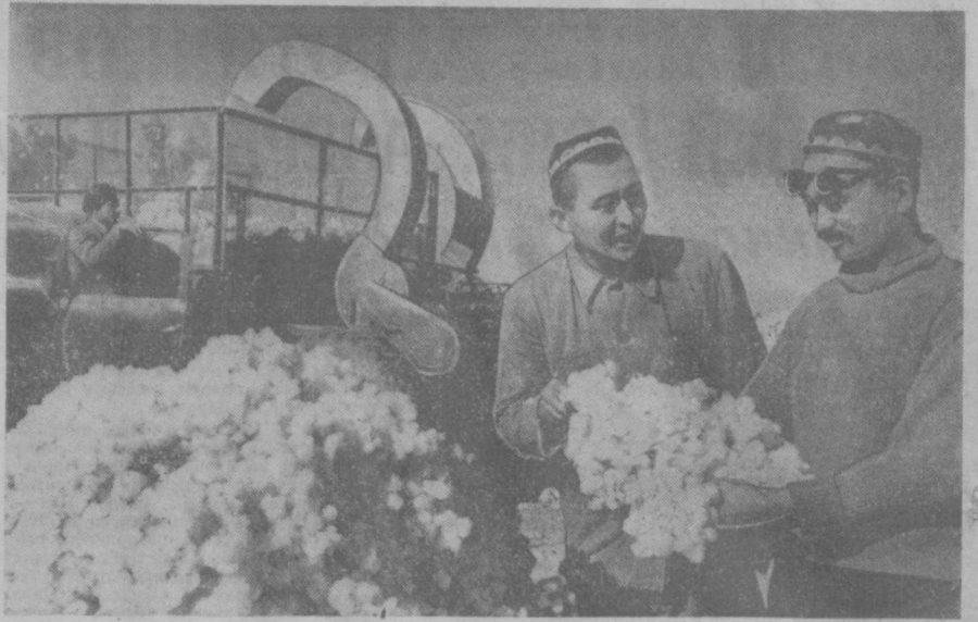
Механизаторы третьего отделения совхоза «Папайрык» Самаркандской области своими силами сконструировали пневматический погрузчик для погрузки хлопка в приемы для бестарной перевозки сырья. Производительность его — 70—80 тонн в день. Сейчас в совхозе монтируются еще два таких погрузчика. НА СНИМКЕ: один из авторов конструкции погрузчика бригадного механика третьего отделения совхоза Турсункула Баймуратов (справа) и агроном отделения Куymbай Кариев. Фото А. Кузьменко. (Фотопрограмма УРАТА).
