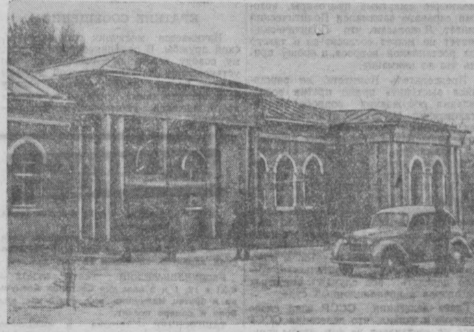
Заканчивается строительство нового здания правления колхоза. Фото М. Пенсона.
