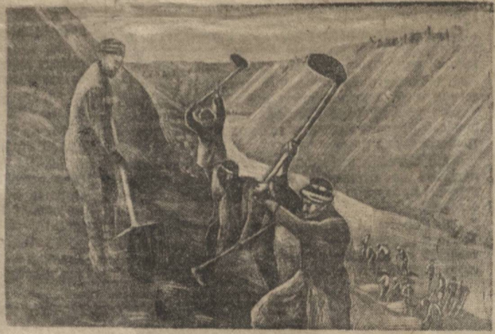
НА СТРОИТЕЛЬСТВЕ НИЖНЕ-ВОСУЙСКОЙ ГЭС. На снимке: земляные работы на первом головном участке строительства. Фото И. Глаубермана. (Фотокроника УзТАП).
