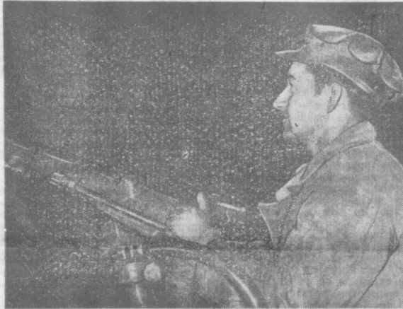
Строители Наусаранского рудника заканчивают прокладку штольничной дамбы почти в пять километров, по которой вода будет доставляться на богатейшую фабрику. Стая на предостройскую трубопроводную вахту, проходчик комсомолец В. Яблоков сменные задания выполняет на 170—175 процентов. Фото В. ЛЕЙЗЕРОВИЧА. (Фотохроника УЗТАГ).
