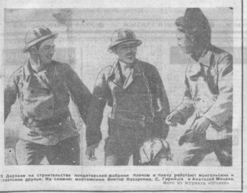
В Дархау на строительной площадке монтajerной фабрики плечом и плечу работают монгольские и советские друзья. На снимке: монтajerный Виктор Назаренко, С. Гиринша и Анатолий Минеев. Фото из журнала «Юность».
