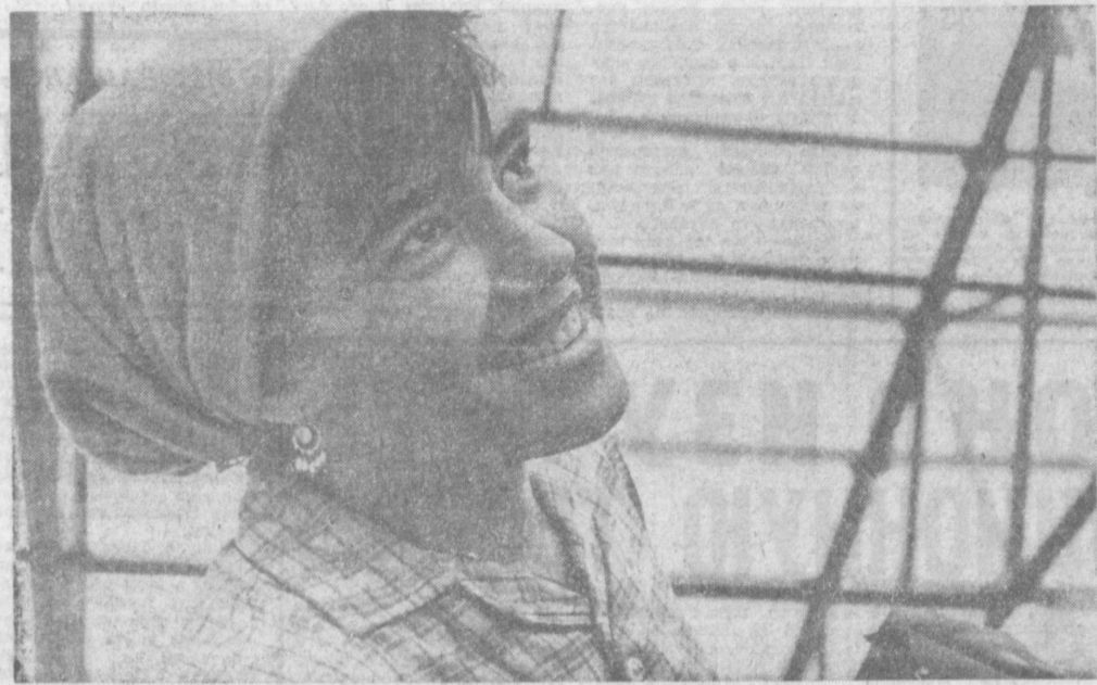
Волонтер коллектива молодежи трудится на строительстве Алмалынского химического завода.
