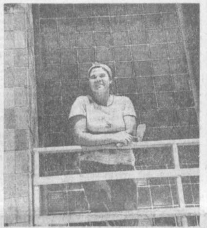
Знатные строители Ташкента, получившие за восстановление узбекской столицы высшие правительственные награды. На верхнем снимке (слева направо): управляющий трестом «Ташинстрой» Абдумуним Абдуладиров награжден орденом Трудового Красного Знамени, бригадир комплексной бригады СУ-22 треста № 159 В. С. Коначинский заслуженно носит ордена «Знак Почета» и строителя СУ-27 треста «Крупнопанельныйстрой» № 1 «Наш Бахавор», награжденный орденом Трудового Красного Знамени, Наталья Фролова Лагутова, штатнатур СУ-169 «Гламострой», которую вы видите на нижнем снимке, награждена орденом Ленина. Фото: В. СИРОТКИНА, И. ГЛАУВЕРЗОНА и Л. ГЛАУВЕРЗОНА.
