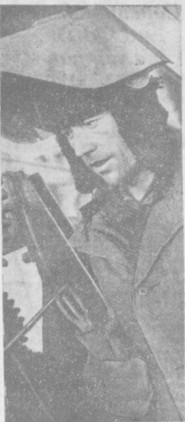
Комсомольцы и молодежь Бухары прилагают все силы к тому, чтобы быстрее сдать в эксплуатацию домостроительный комбинат. Сейчас здесь идет монтажные работы, в цехах устанавливается оборудование. НА СНИМКЕ: электросварщик Иван Михайлов. На обложке — раскладочные машины на систематически выполняются сменные задания.
