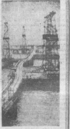
АЗЕРБАЙДЖАН СКАЯ ССР. Более чем на двести километров протоптали дороги морских эскадр на Каспии. Связанные, пробуренные в этих морских дорогах, дают более 30 процентов нефти, добываемой в республике. На снимке: морские нефтепромыслы управления имени Серебрянского.
