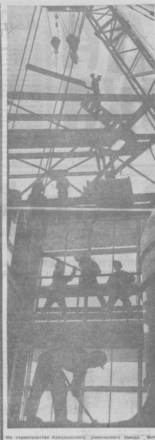
На строительстве Алмалыкского химического завода. Монтажные работы ведет бригада Г. Пуртова. Фото Р. ДЖУМАНИЯЗОВА.
