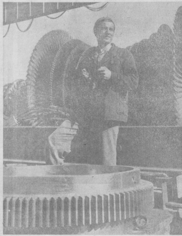
С первых дней строительства Ташкентской ГРЭС работает здесь слесарь-турбинник Виктор Рыбов. Сейчас он занят на монтаже девятой турбины.
