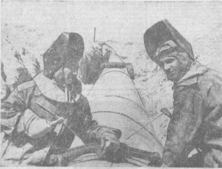
Успешно идет строительство второй очереди газопровода «Средняя Азия—Центр». На этом строительстве отлично трудится коллектив СМУ-5 треста «Нефтепроводмонтаж». На снимке: передовые электросварщики Р. Джумамуратов и Г. Посохин. Фото Р. ДЖУМАНИЗОВА.
