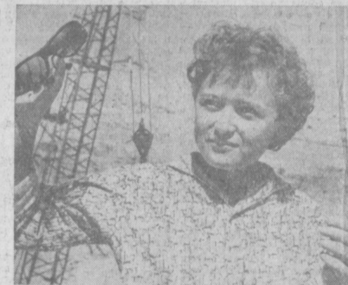
Уникальная насосная станция № 5 сооружается на трассе Каршинского магистрального машинного канала. После сдачи в эксплуатацию станция будет пропускать в секунду до 350 кубических метров воды. На снимках: вверху — один из участников строительства насосной; внизу — мастер участка строительства насосной станции комсомолец Сара Мустакаева. Со своими обязанностями она справляется отлично.
