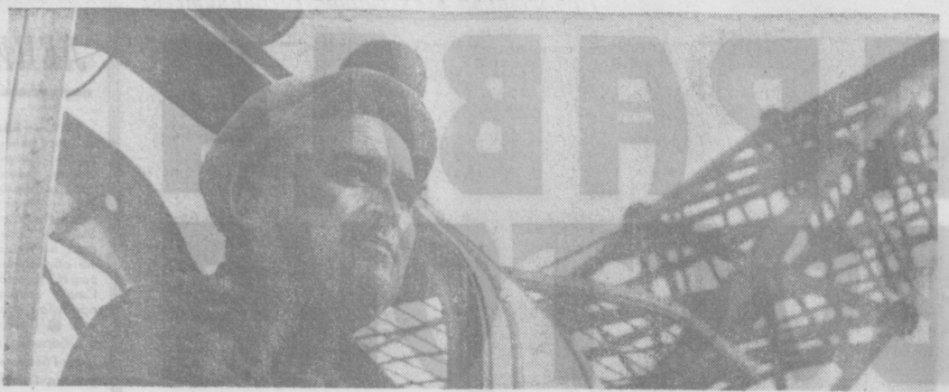
Управления треста «Ферганаводстрой» развернули работы по строительству гидротехнических сооружений и русла второй очереди Центрального Ферганского канала — его конечной 12-километровой части. С вводом в действие этой части канал сможет орошать до 23 тысяч гектаров земель центральной Ферганы, часть из которых уже освоена и орошается водами БФН, а часть еще в процессе освоения. На снимке: лучший крановщик СМУ-3 Петр Исифрович Мильман регулярно перевыполняет нормы на строительстве. Фото Г. БОЛКОВ (УТАГ).
