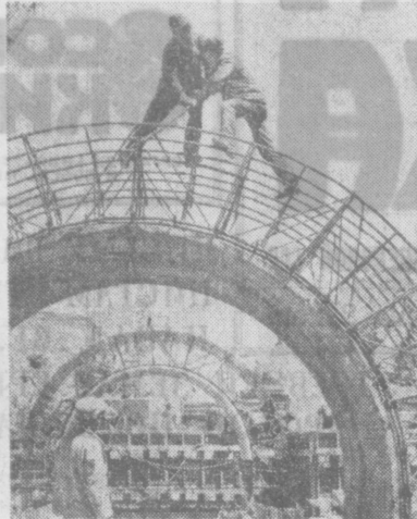
Бригада сварщиков-монтажников Г. Т. Трегубова ведет установку армокаркасов основания плотины Нурекской ГЭС.
